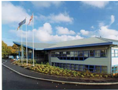
Fig. 7.1. Instalaciones del Centro Técnico de Belron®.
