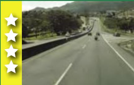
Carretera de dos direcciones con barrera en la mediana, intersecciones separadas por niveles y buena delineación
