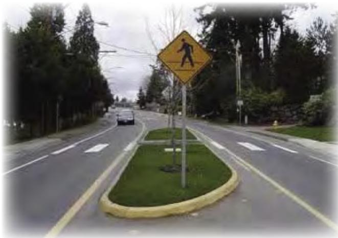
Carreteras **compasivas** son diseñadas para proteger a los usuarios de la carretera en caso de un accidente. El diseño de la carretera tiene que reconocer que pueden ocurrir accidentes y asegurar que las muertes y heridas sean minimizadas protegiendo a los usuarios de los peligros. Elementos de ingeniería, como barreras de seguridad, se pueden utilizar para separar el tránsito de vehículos a gran velocidad de las personas y para amortiguar los choques cuando ocurren.
