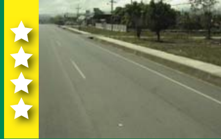
Camino asfaltado separado del tránsito mediante una zanja profunda
