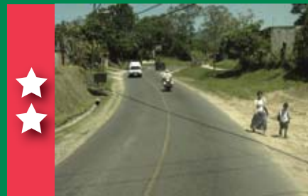
Arcén sin asfaltar para el uso de peatones
