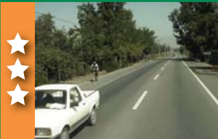
Arcén pavimentado para el uso de bicicletas
